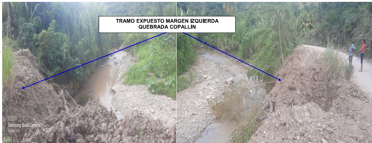
IMAGEN N°04: OTRO TRAMO DEL SECTOR PALACIOS EN LA QUEBRADA COPALLIN QUE SE ENCUENTRA DESPRENDIENDO DEL TALUD AFECTANDO A LA CARRETERA.
